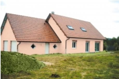
La PV 10 Huguenot est une tuile terre cuite de la marque IMERYS Toiture. Elle est fabriquée en France, comme tous les produits terre cuite du groupe. La tuile PV 10 Huguenot est un modèle à grand moule et à emboîtement à relief. Elle est façonnée et cuite soit à Saint-Germer-de-Fly dans le Beauvaisis et soit à Pargny-sur-Saulx. La tuile PV 10 Huguenot est une tuile grand moule à côte et à double emboîtement.
